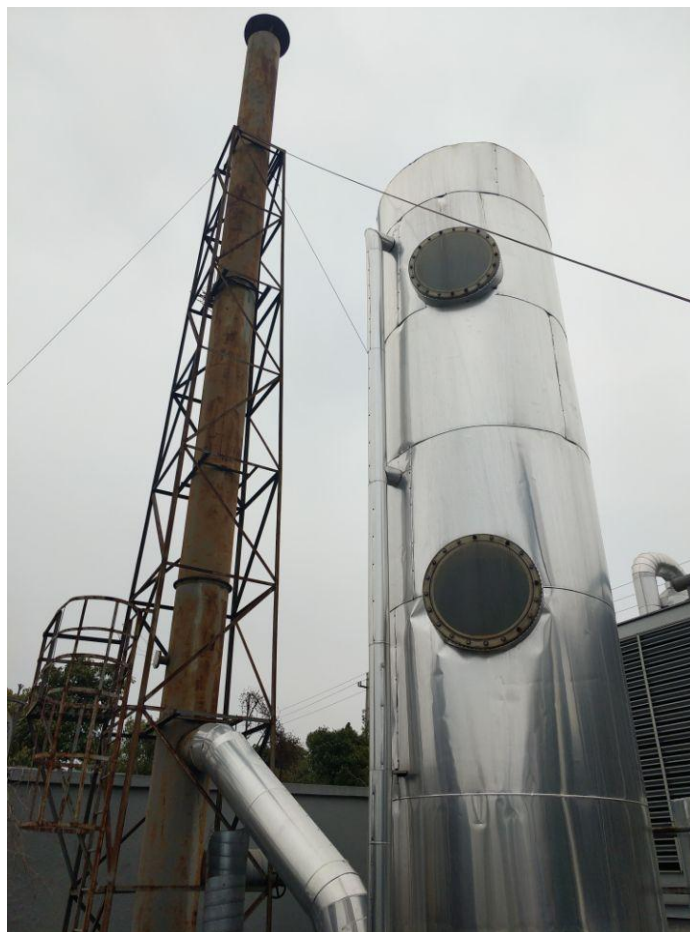
图 4-5 本项目主要废气治理设施 3（排气筒）
