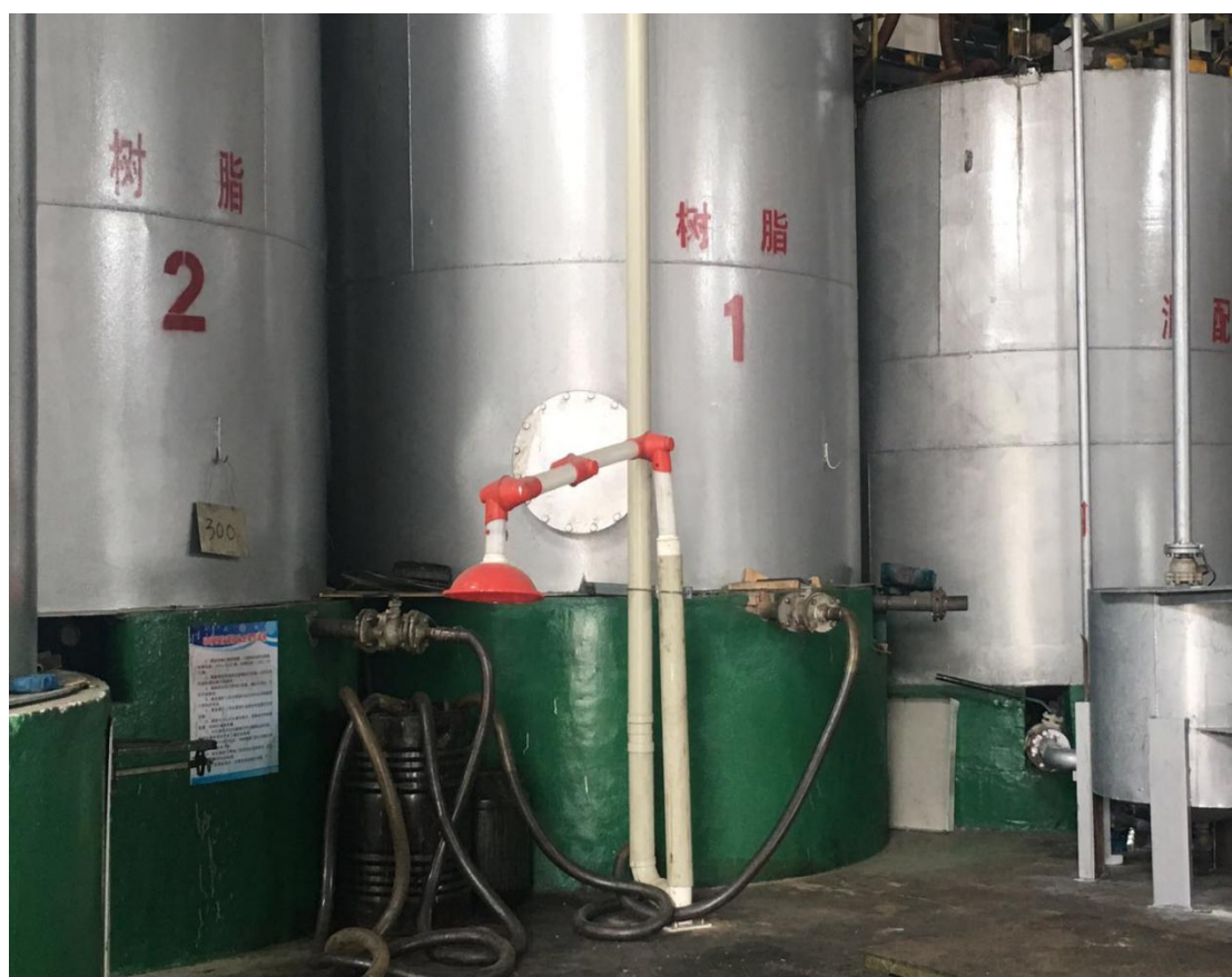
图 4-7 本项目主要废气治理设施 5（抽成品时的废气吸收装置）
