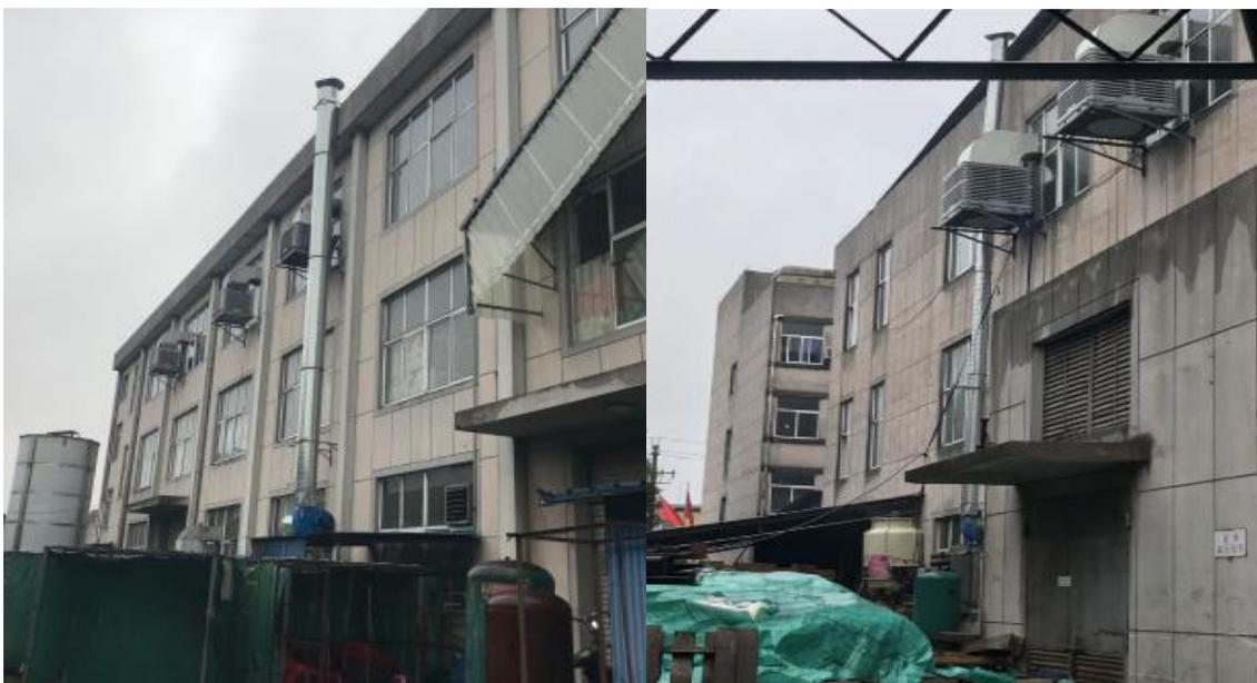
图 4-2 本项目吸塑、挤塑废气排气筒图片
