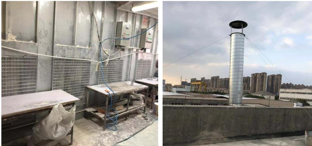
图 4-3 本项目主要废气治理设施 1（砂光粉尘）
