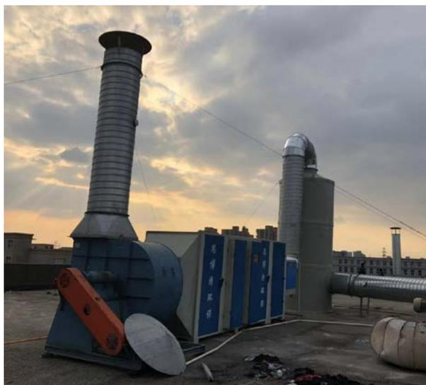
图 4-3 本项目主要废气治理设施 3（喷漆废气处理设施）
