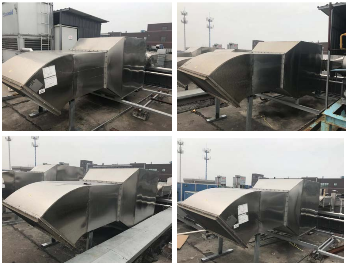
图 4-4 本项目主要废气治理设施（生物酶臭气治理器）
