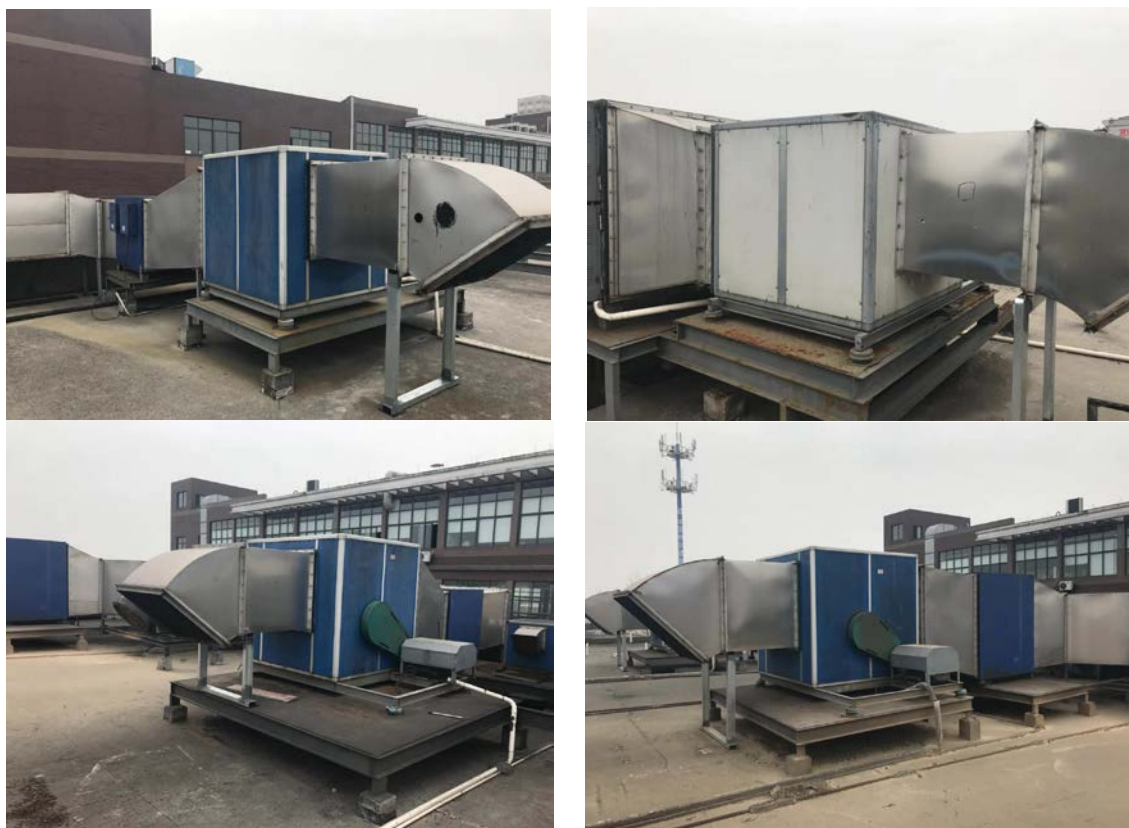
图 4-4 本项目主要废气治理设施（生物酶臭气治理器）
