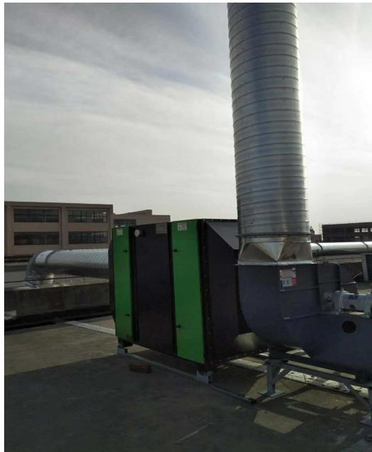
图 4-2 本项目主要废气治理设施 1 (有机废气)
