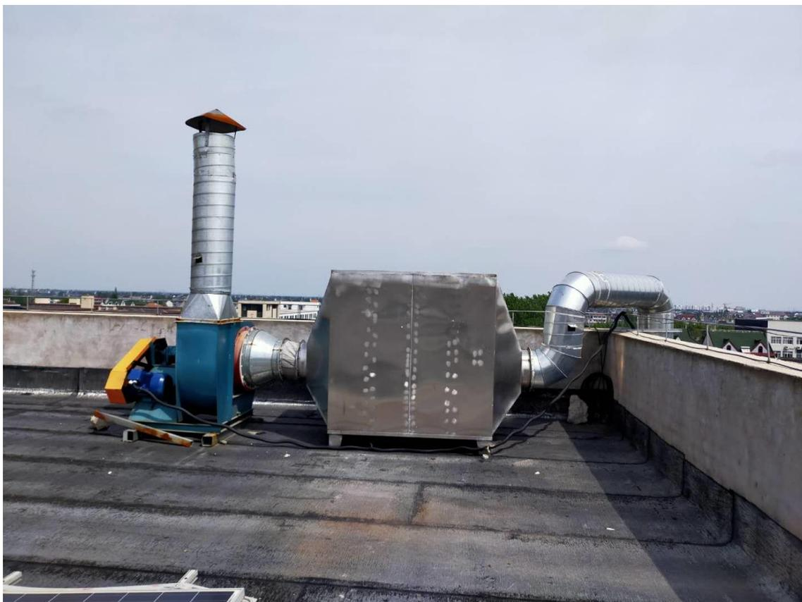
图 4-2 本项目有机废气处理设施图片
