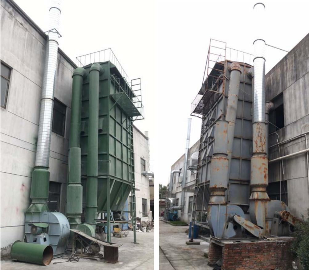
图 4-5 本项目主要废气治理设施（制扣粉尘）
