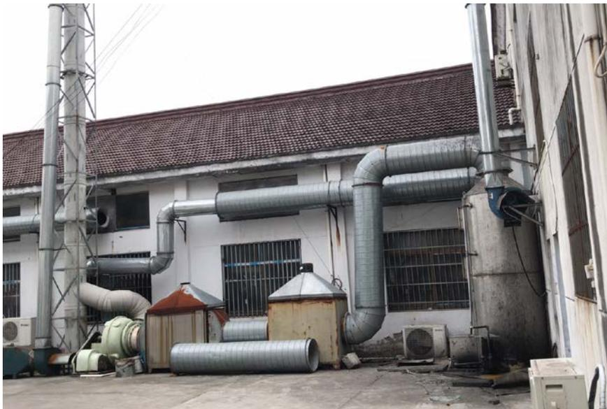
图 4-6 本项目主要废气治理设施（激光雕刻废气）
