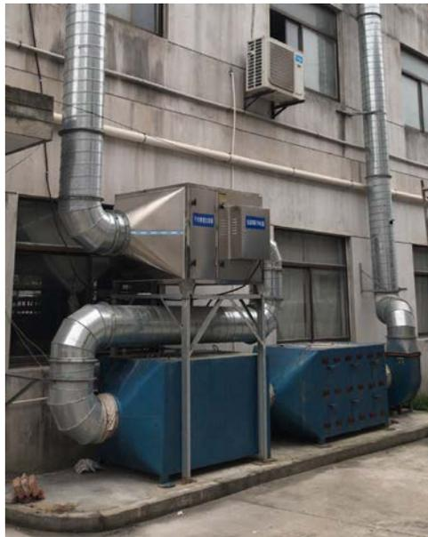
图 4-4 本项目主要废气治理设施（坯料生产废气）
