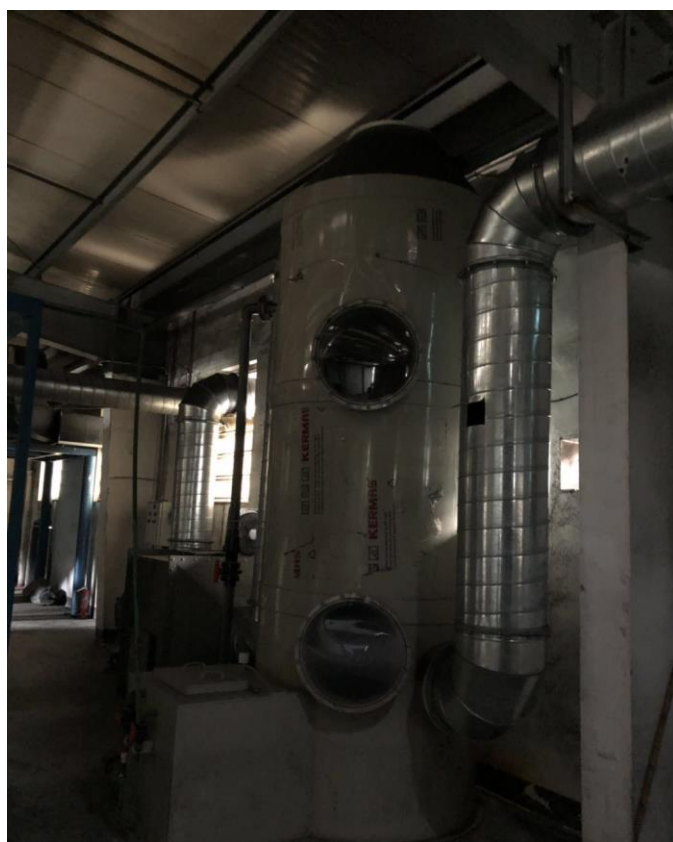
图 4-11 本项目喷塑粉尘处理设施图片（西北面车间 2 楼）
