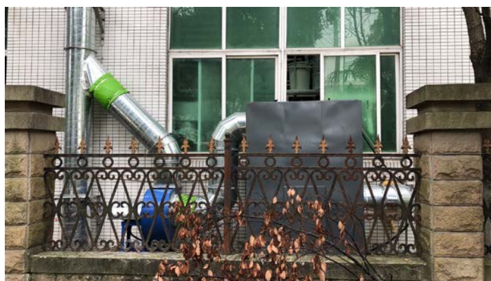
图 4-3 本项目主要废气治理设施（除尘系统）
