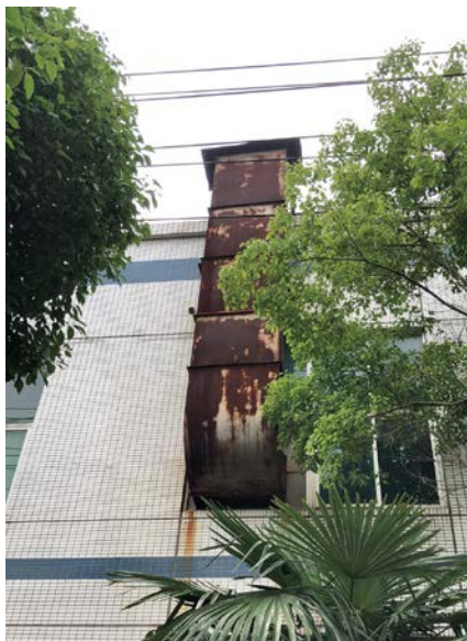
图 4-4 本项目主要废气收集设施（有机废气）
