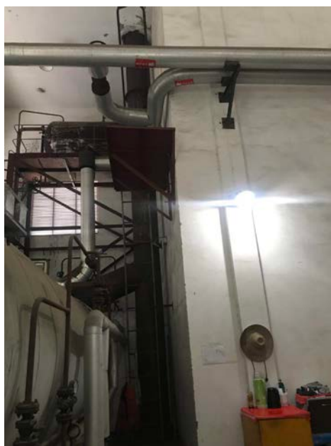
图 4-5 本项目主要废气收集设施（锅炉废气）
