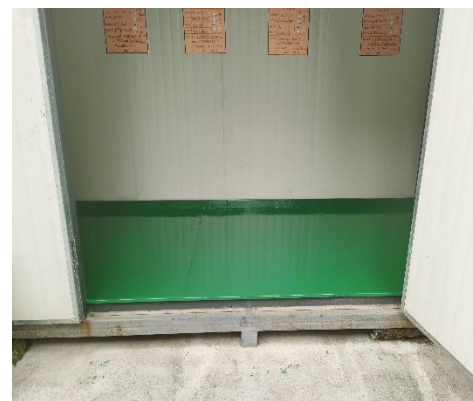
危废仓库环氧地坪漆
