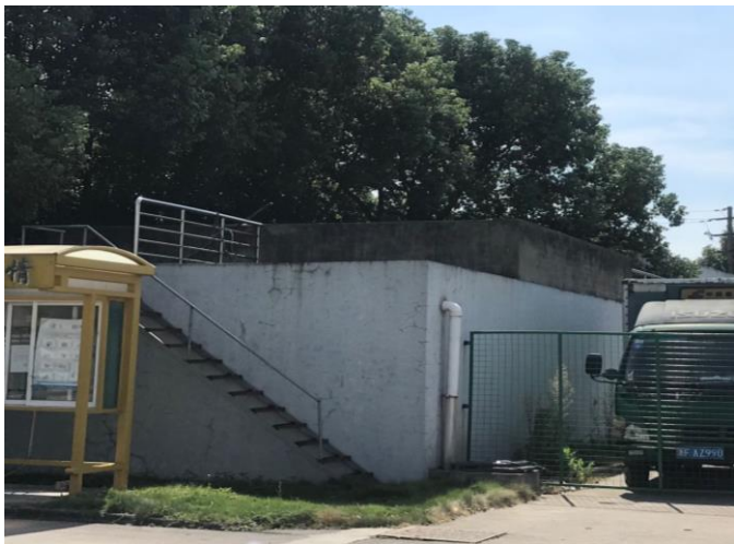
图4-1 废水处理设施现场图
