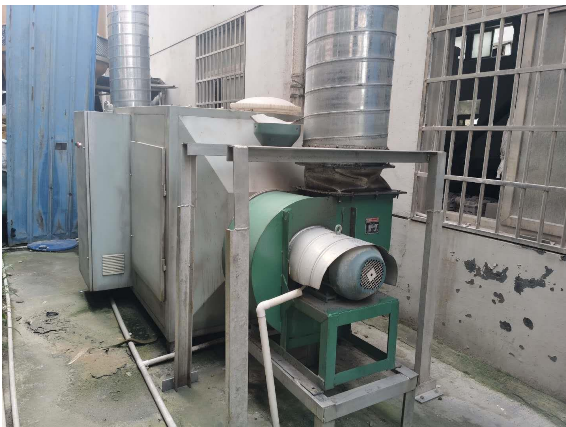
图 4-4 本项目注塑废气治理设施图片
