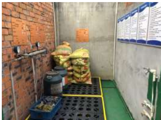
图 4-3 本项目危废仓库图片
