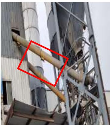
图 4-7 水泥螺旋输送机
