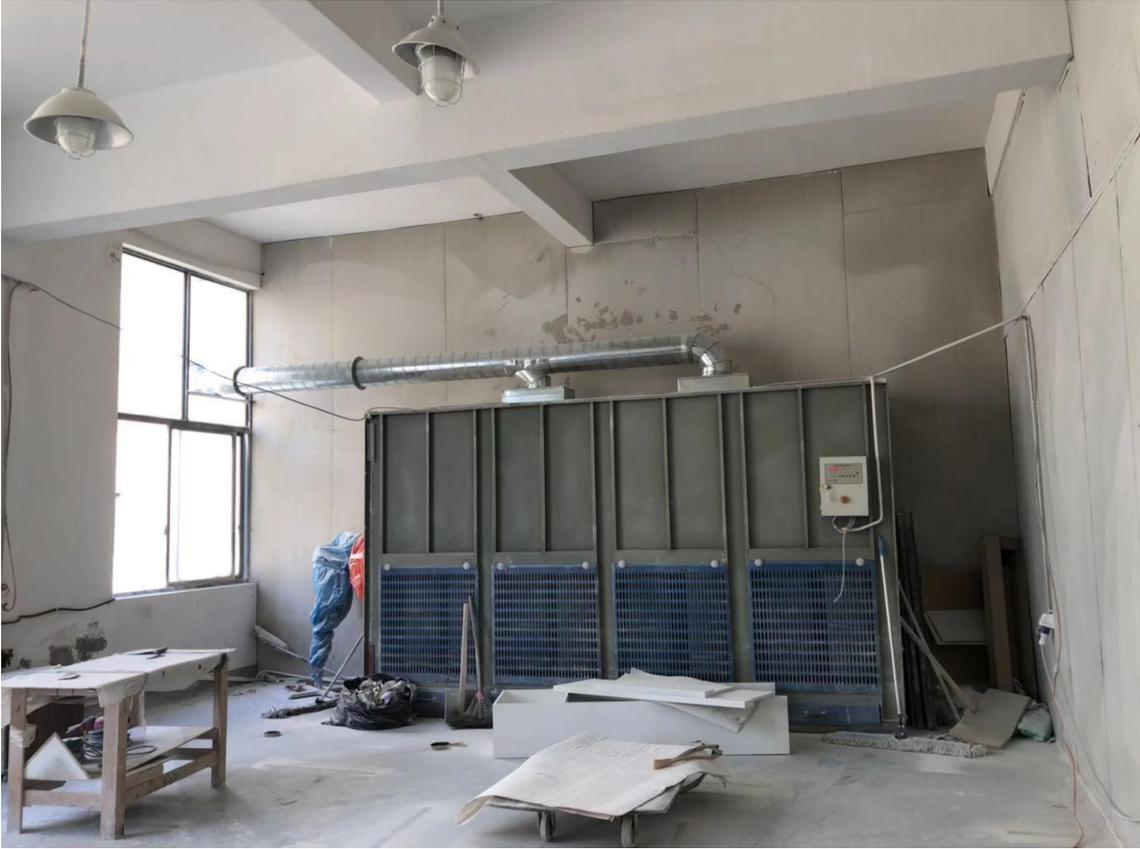
图 4-5 2 套脉冲布袋除尘设施图片
