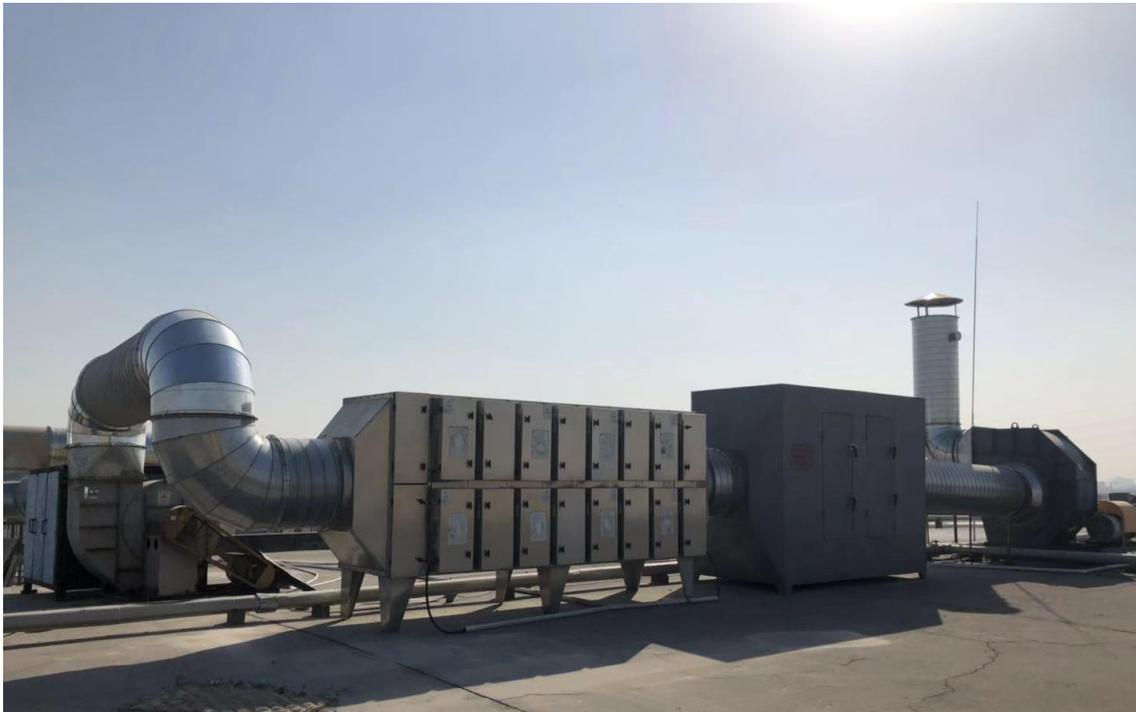
图 4-8 喷漆废气处理设施图片
