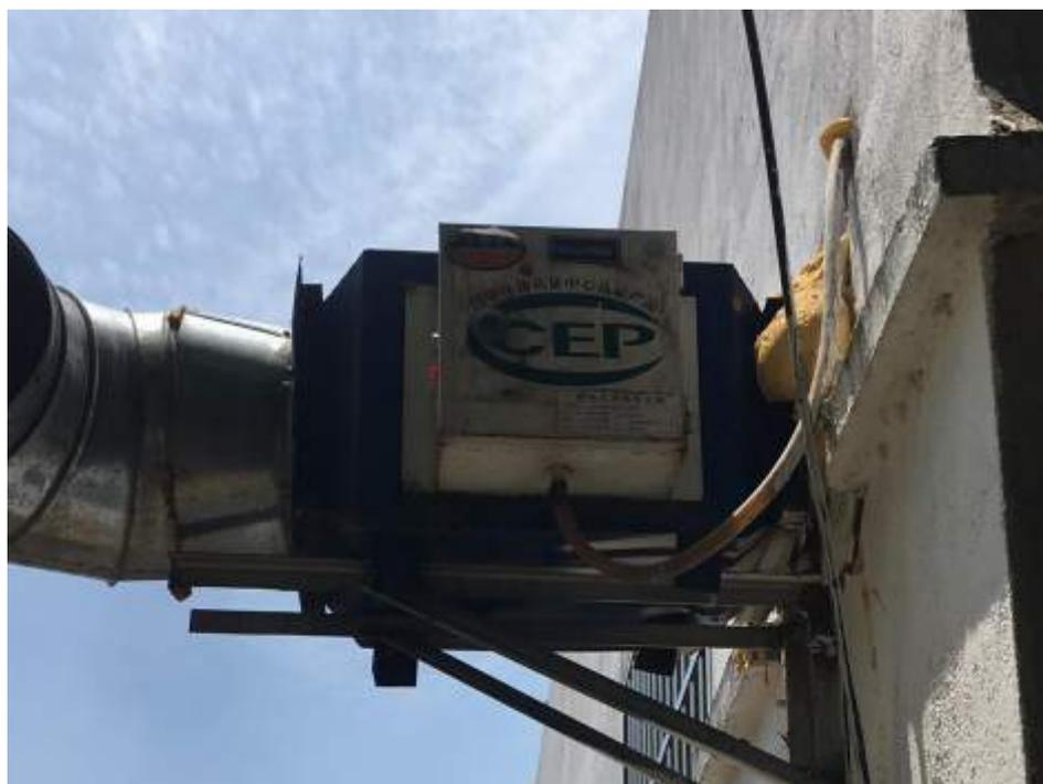
图 4-3 本项目油烟废气处理设施图片
