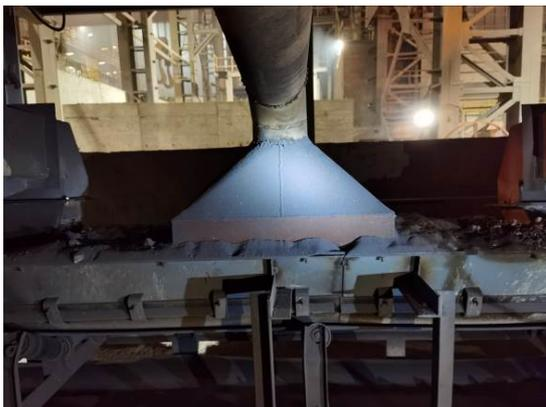
原辅料高位料仓与封闭皮带通廊连接处安装集气罩
