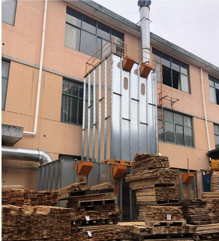
图 4-2 本项目脉冲布袋除尘设施图片
