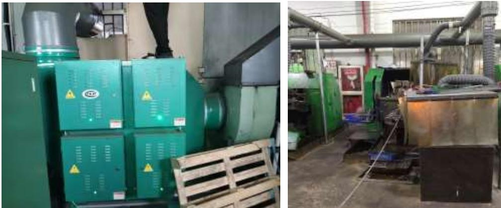
图 4-2 本项目油雾废气处理设施图
