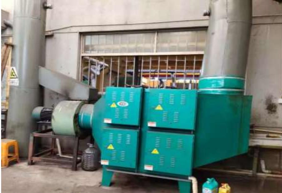
图 4-2 本项目油雾废气处理设施图
