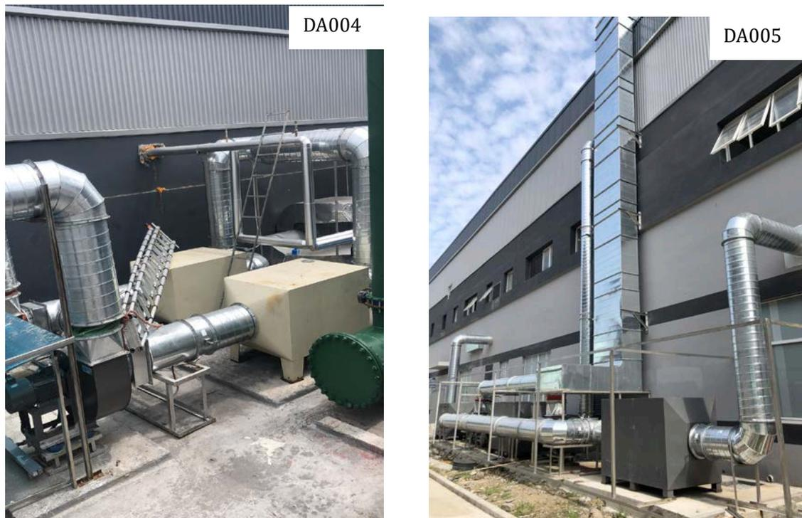
图 4-2 有机废气处理设施
