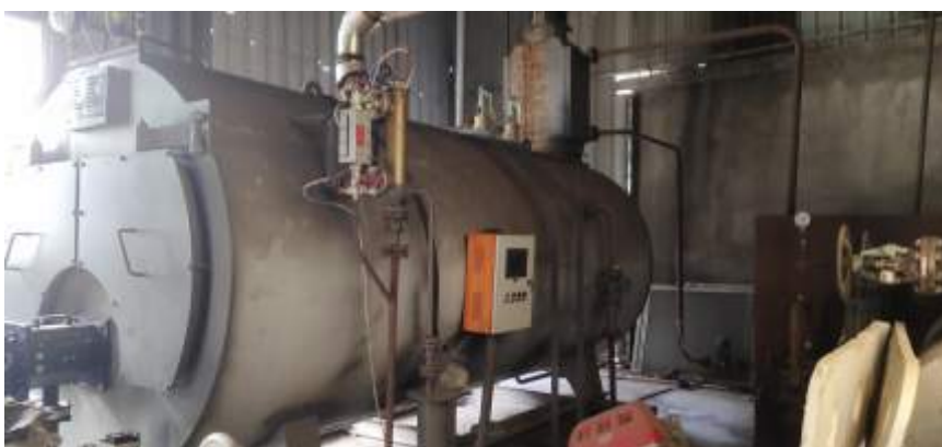
图 4-2 本项目锅炉燃烧废气治理设施图
