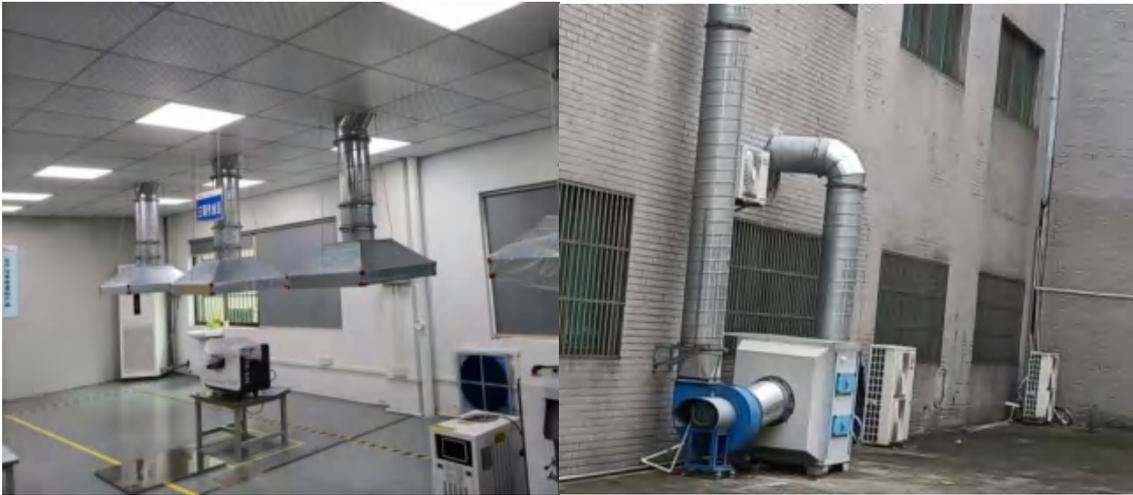
图 4-2 本项目有机废气治理设施图片
