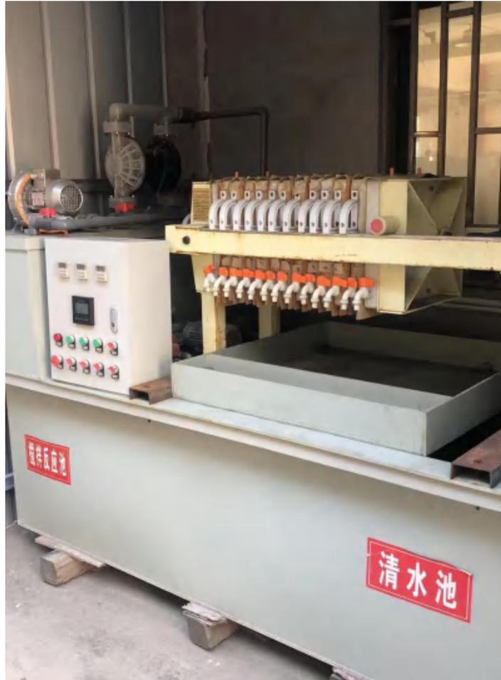
图 4-2 生产废水处理图片
