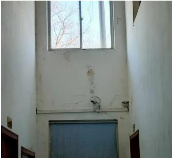
图 4-4 本项目危废仓库图片
