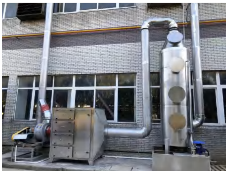
图4-8喷塑烘干废气治理设施图片
