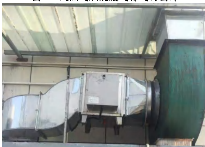
图4-12食堂油烟净化装置图片
