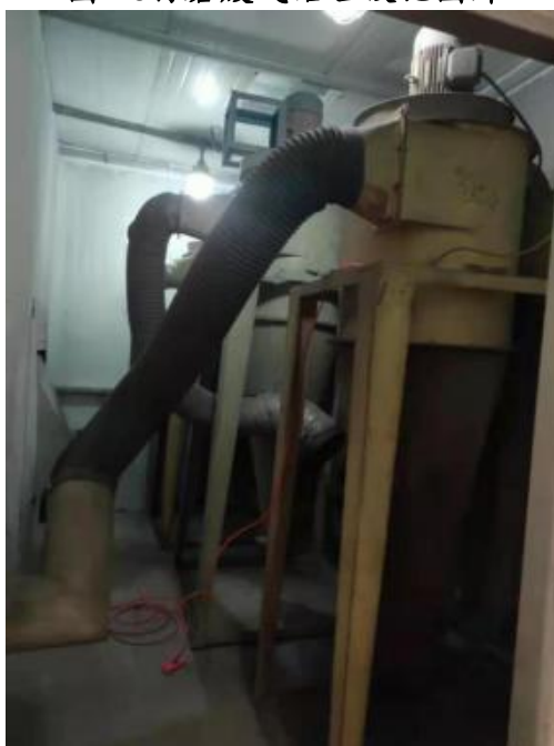
图4-6打磨废气治理设施图片
