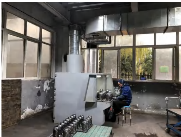
图4-6打磨废气治理设施图片
