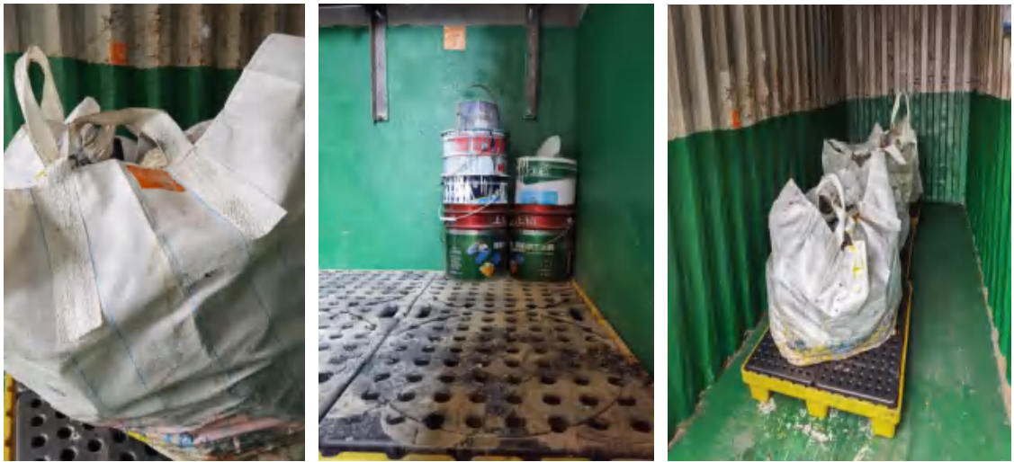
图 4-10 本项目危废仓库防渗漏托盘和标志标贴
