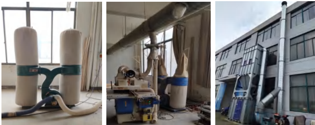
图 4-5 本项目木屑粉尘处理设施图
