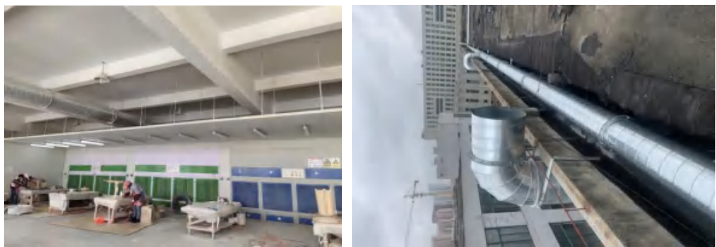
图 4-4 本项目油漆粉尘处理设施图
