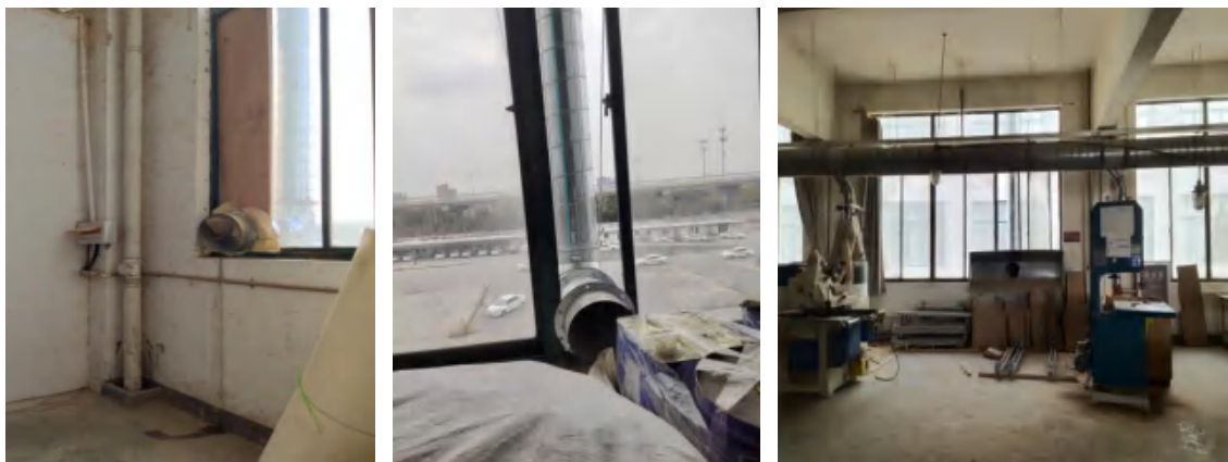
图 4-7 本项目综合废气处理设施图
