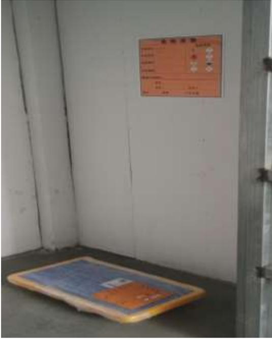
图 4-1 防渗漏托盘和危废种类标识
