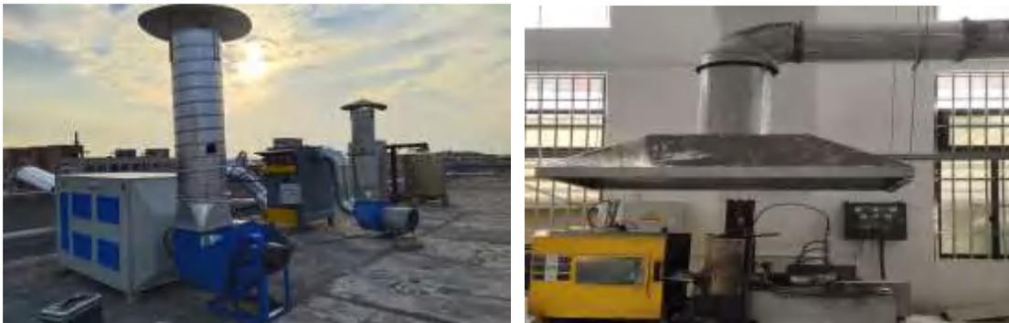
图 4-4 本项目 3#熔化及压铸废气处理设施和 3#注塑废气处理设施照片
