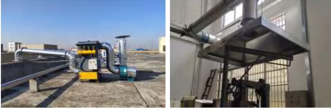
图 4-6 本项目 2#熔化及压铸废气处理设施照片
