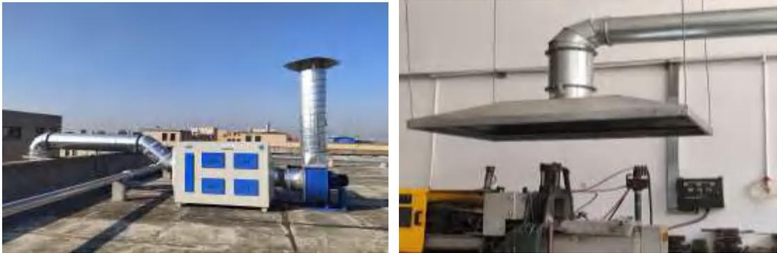
图 4-7 本项目 2#注塑废气处理设施照片
