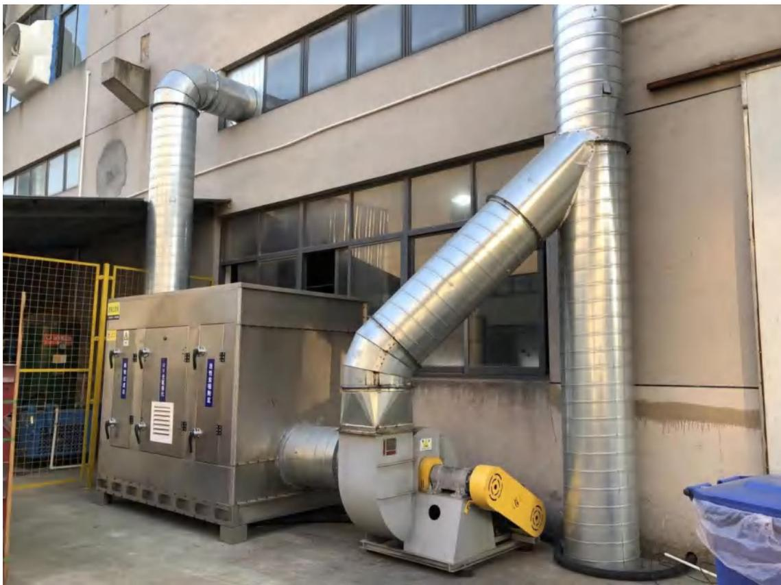
图4-4 燃烧、固化废气处理设施图片
