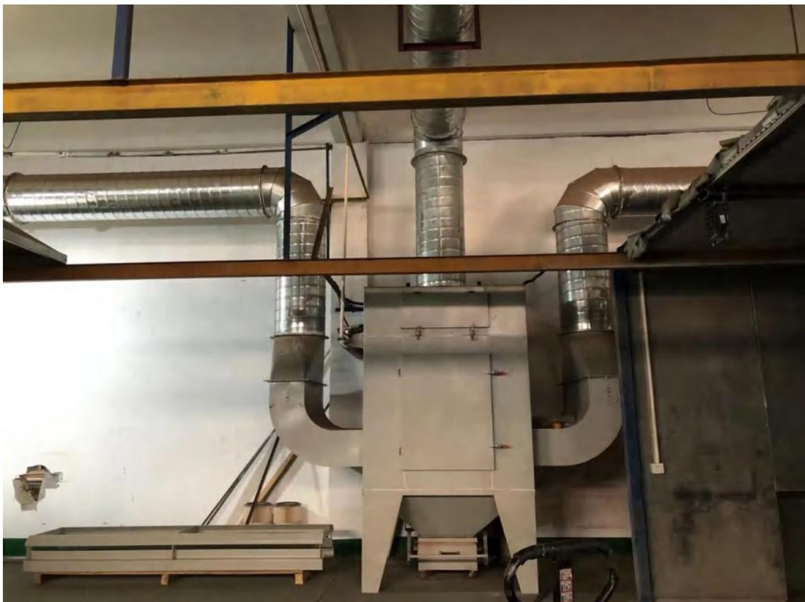
图4-3 喷塑废气处理设施图片
