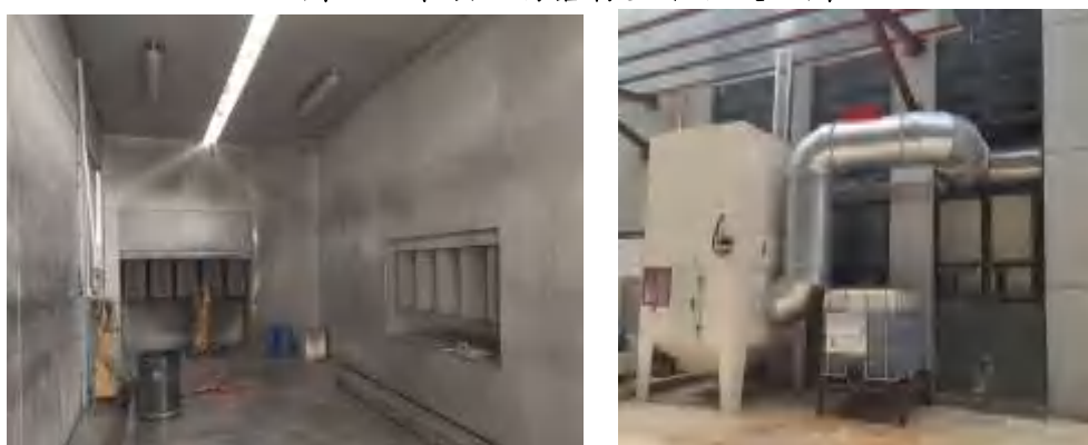
图 4-6 本项目打磨粉尘治理设施图
