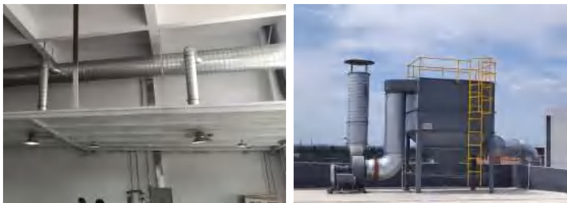
图 4-5 本项目焊接烟尘治理设施图
