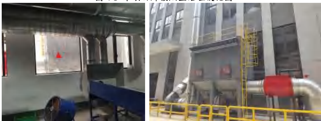
图 4-6 本项目打磨粉尘治理设施图
