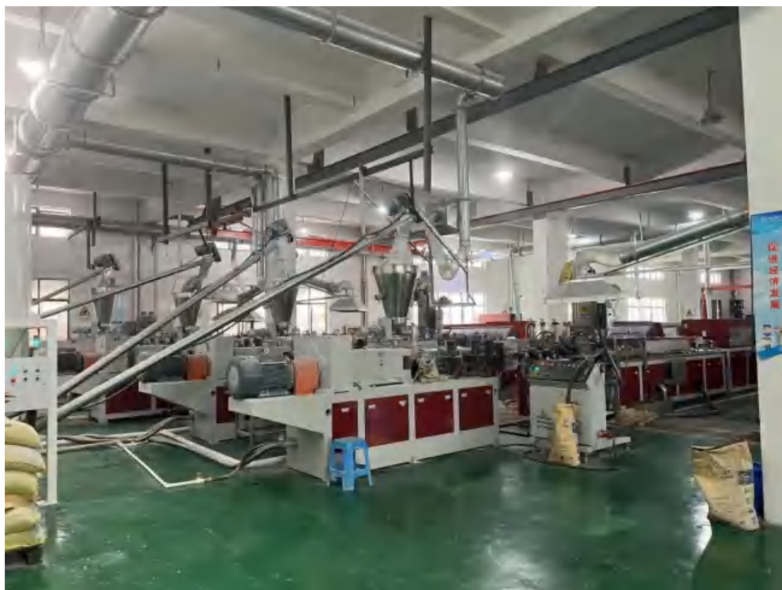
图 4-3 本项目挤出工序废气收集设施图片
