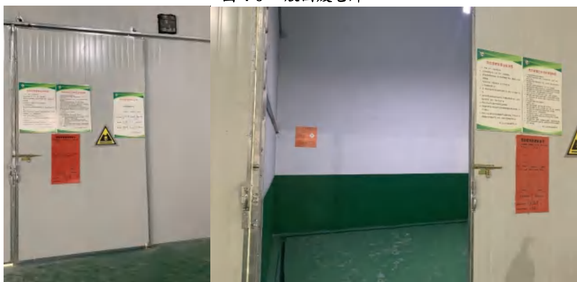
图 4-7 危险废物仓库
