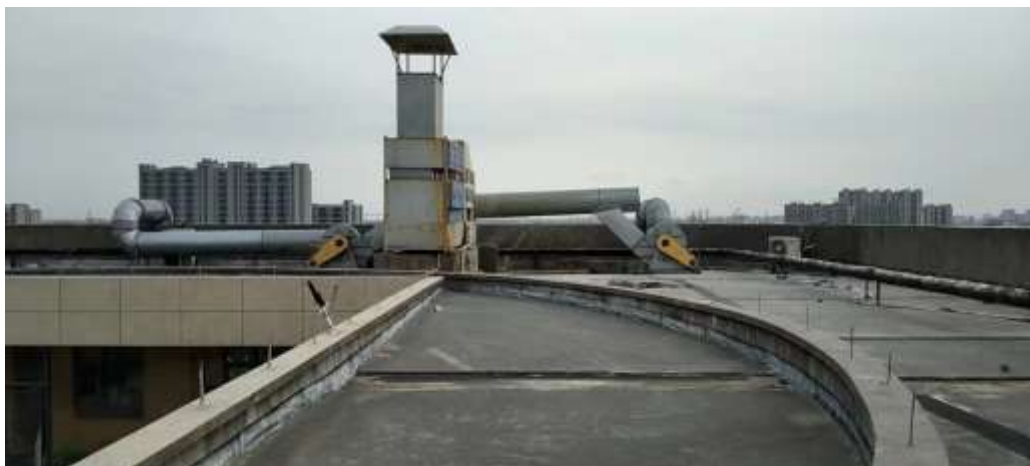
图4-5喷漆、晾干废气处理设施图片
