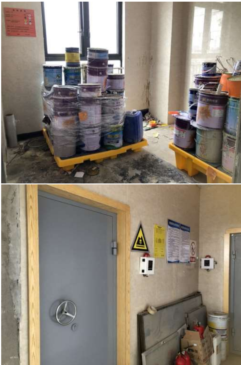
图4-8危险废物仓库
