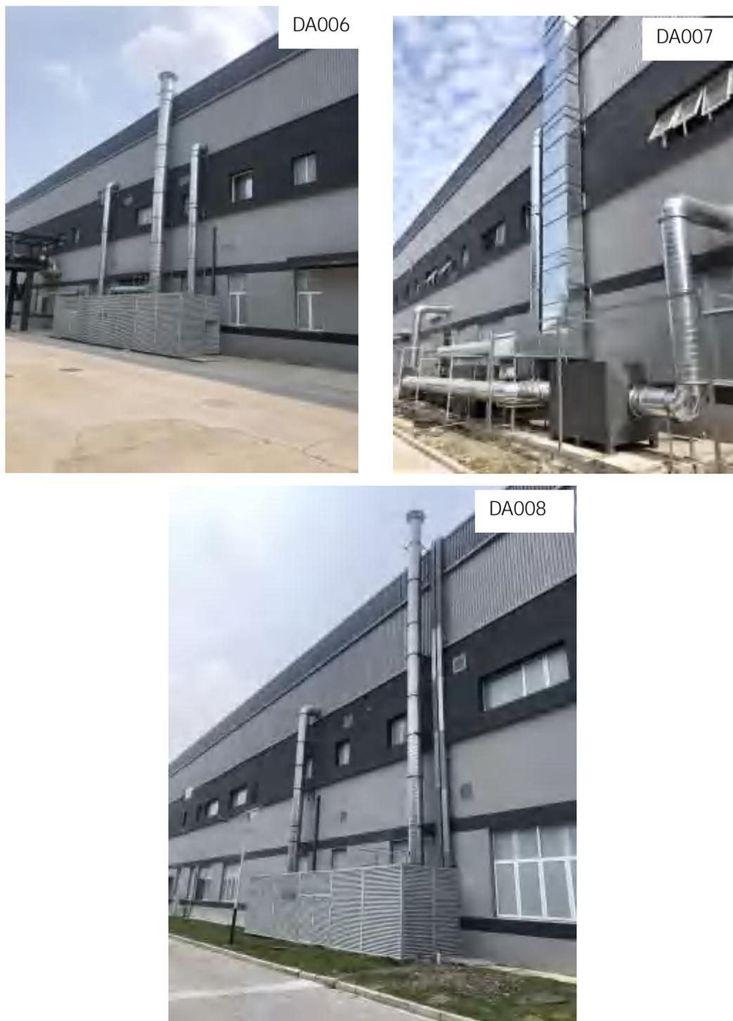
图 4-2 有机废气处理设施
