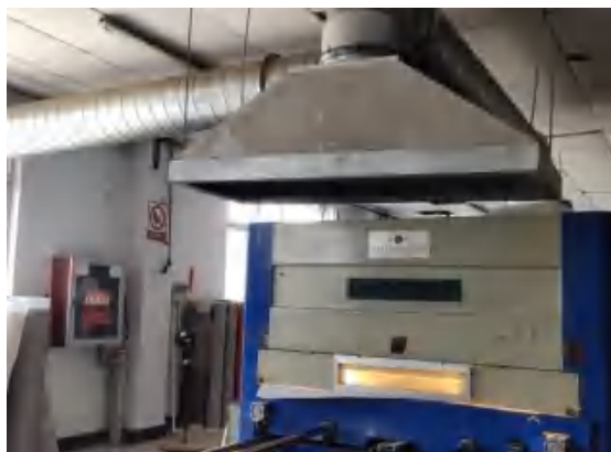
图 4-2 胶水废气治理设施图
