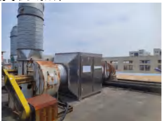
图 4-4 2#喷漆废气治理设施图
