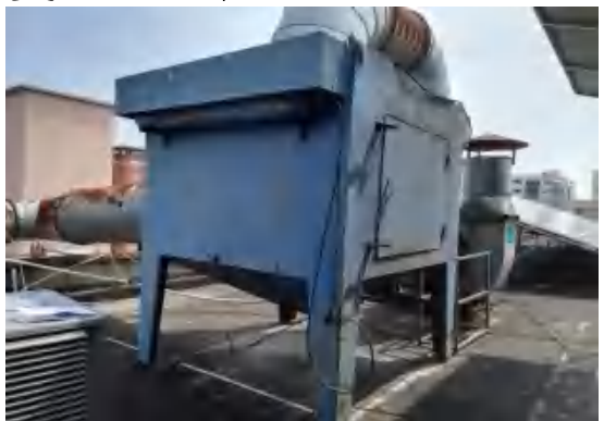
图 4-5 1#打磨工序粉尘治理设施图
