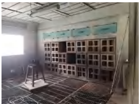
图 4-3 1#喷漆废气治理设施图
