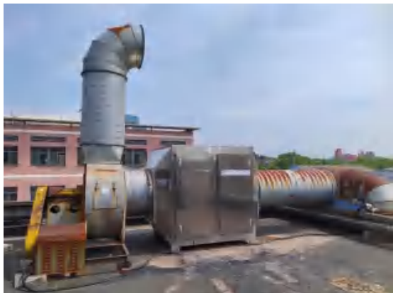
图 4-3 1#喷漆废气治理设施图
