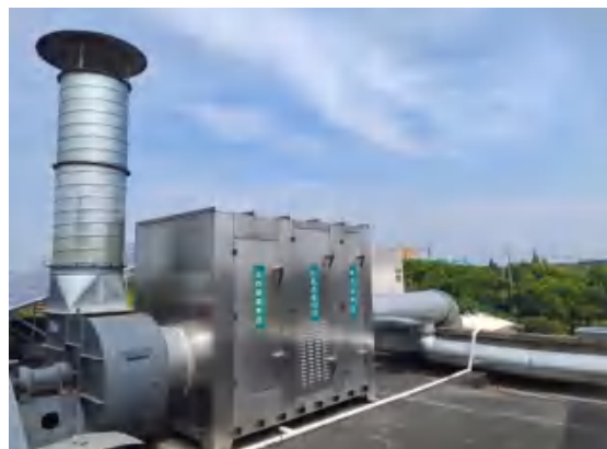
图 4-2 胶水废气治理设施图
