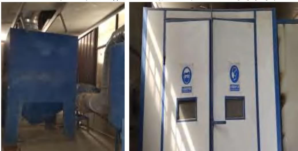
图 4-5 本项目喷砂废气治理设施图
