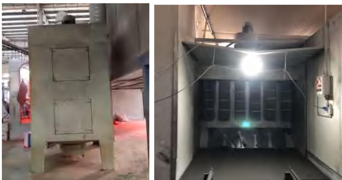
图 4-8 本项目喷塑废气治理设施图
