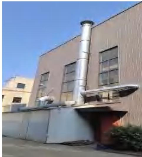
图 4-4 本项目喷砂、抛丸粉尘、固化、燃烧废气排气筒
