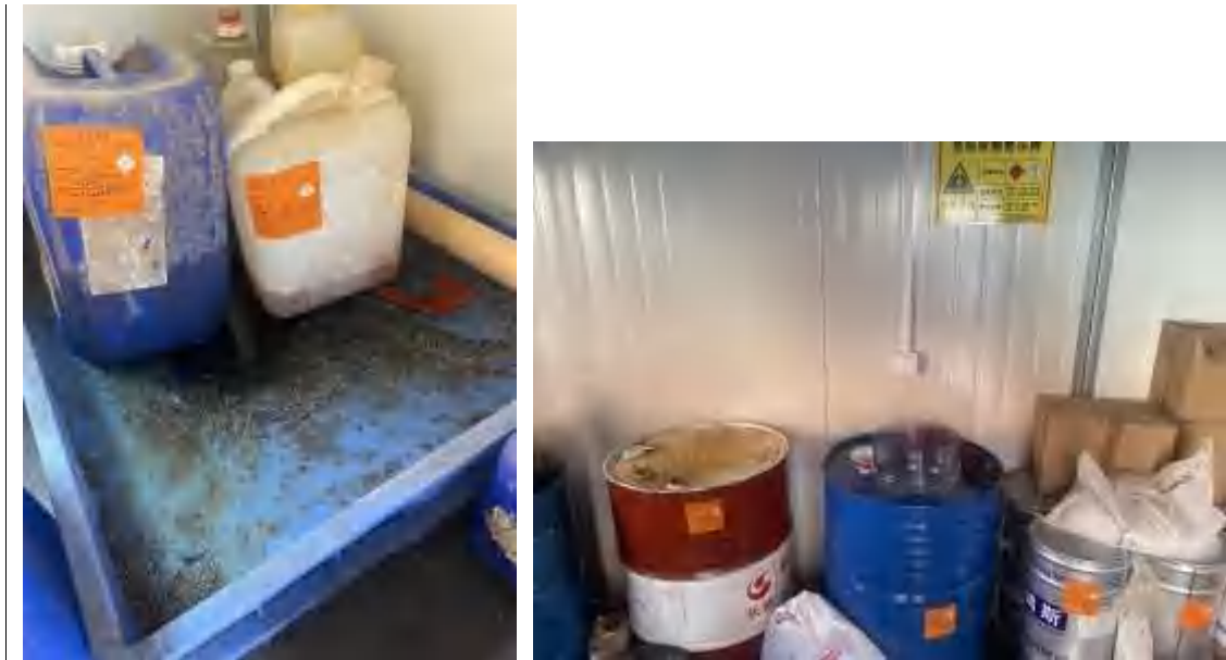
图 4-4 危险废物仓库托盘、警示牌
