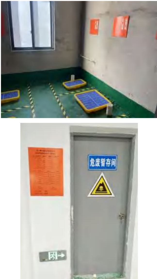
图 4-3 危险废物仓库
