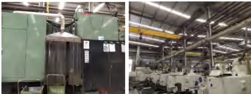
图 4-7 成型油雾废气集气罩
