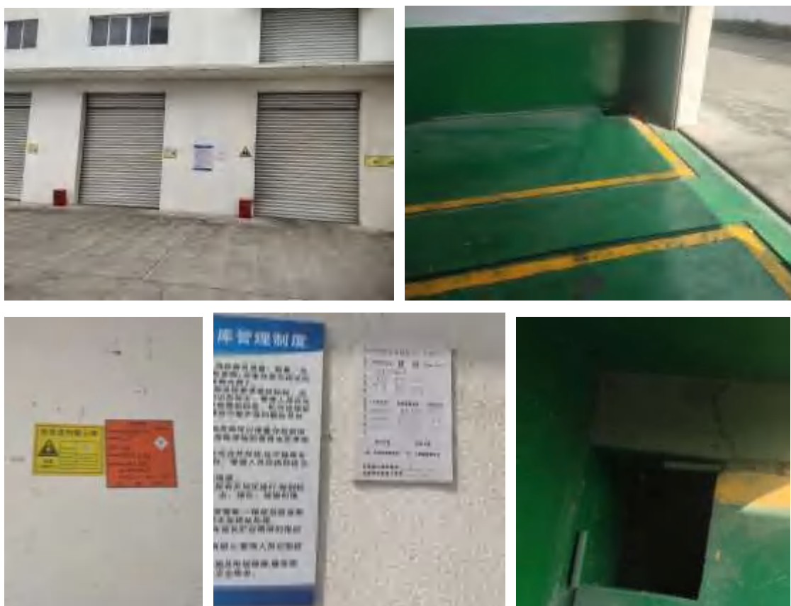
图 4-6 危险废物仓库
