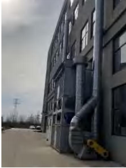
图 4-4 本项目木加工工序废气处理设施图片
