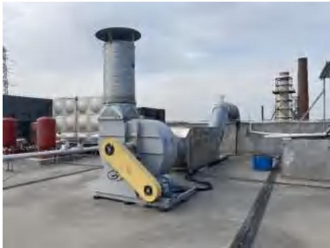
图 4-5 本项目面漆、晾干工序废气处理设施图片
