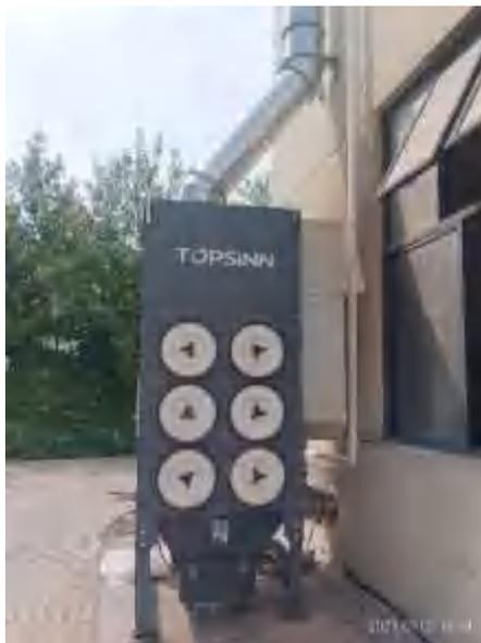
图 4-3 本项目 2#激光切割、抛光粉尘处理设施图片 (1号、2号切割机、抛光机)
