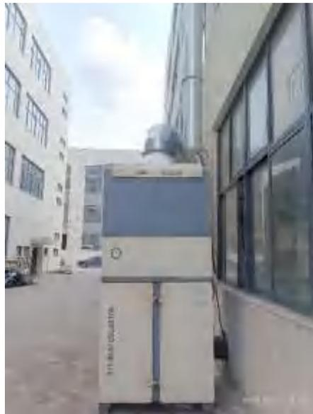
图 4-2 本项目 1#激光切割粉尘废气处理设施图片 (3号切割机除尘设施)
