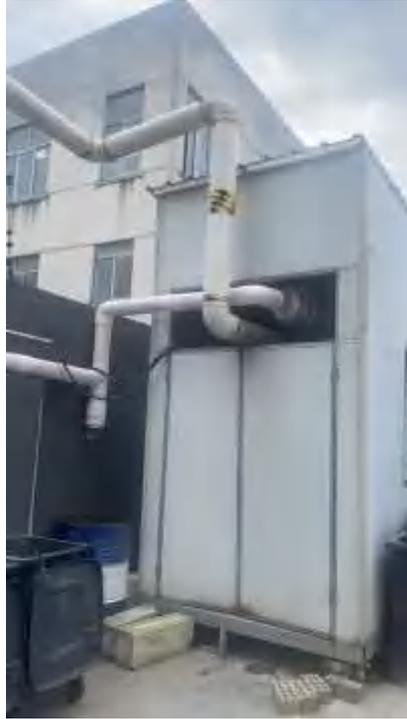
图 4-2 本项目喷砂废气处理设施图片
