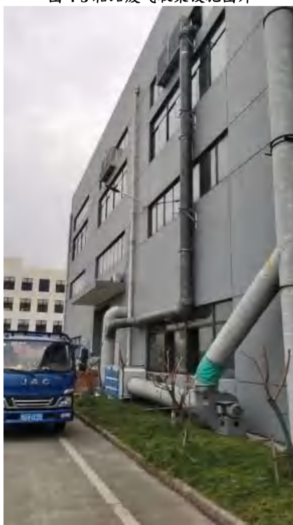
图 4-4 本项目打印、粘接废气处理设施图片
