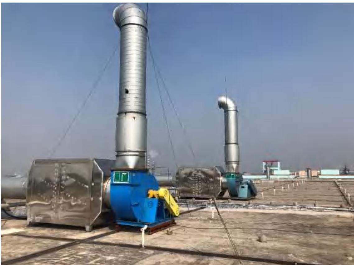
图 4-4 本项目喷漆废气治理设施
