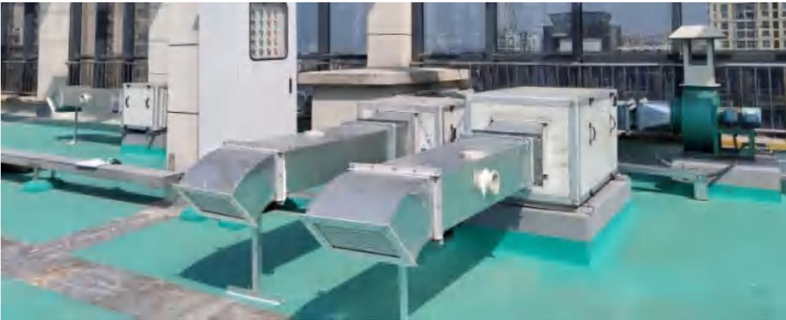
图 4-5 本项目生化实验室废气治理设施
