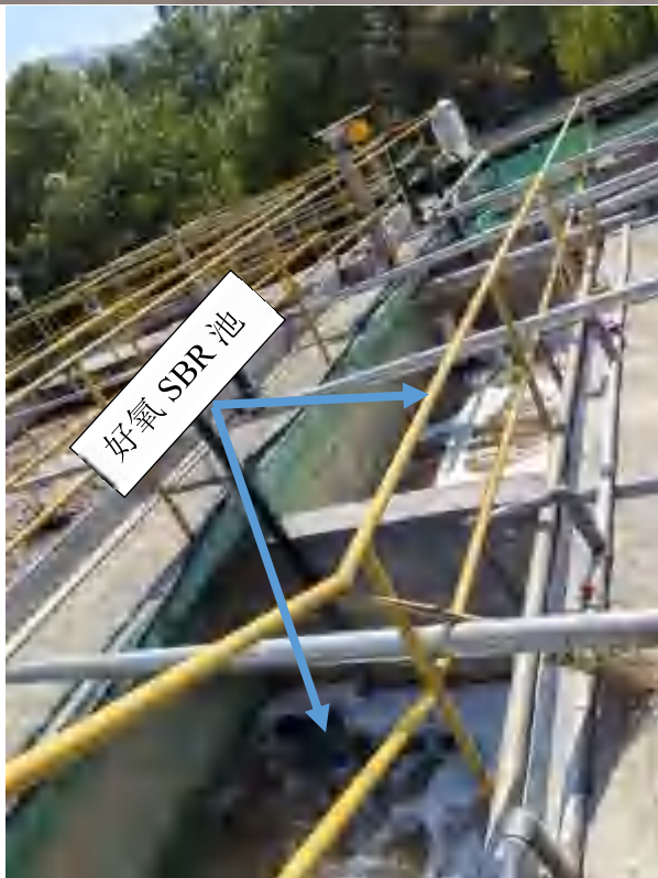
图4-2 生产废水处理设施照片
