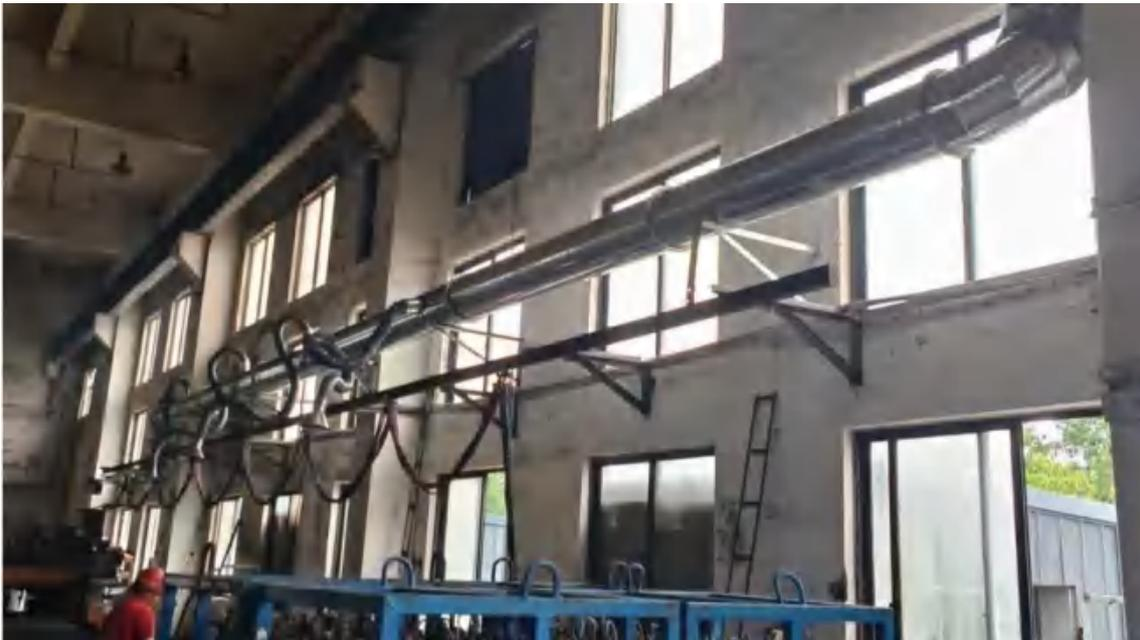
图 4-4 本项目切割烟尘集气罩收集设施
