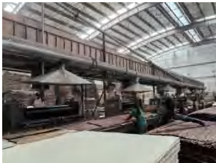
图 4-7 涂胶废气收集设施图片
