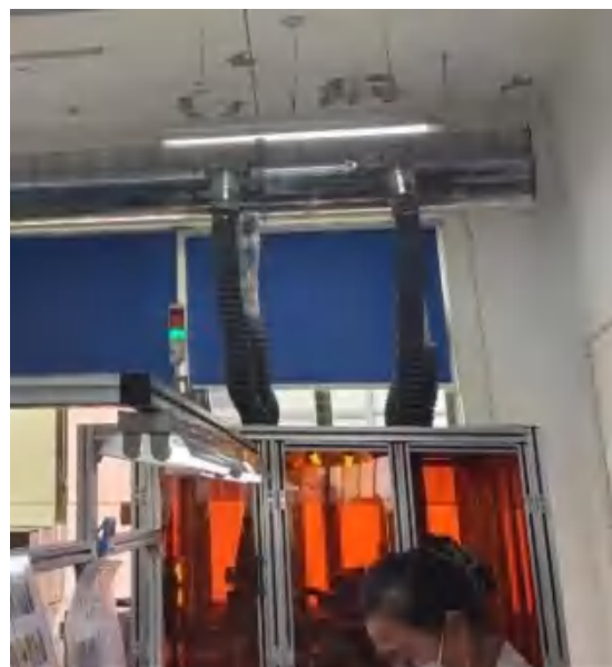
图 4-2 本项目焊锡废气集气罩收集
